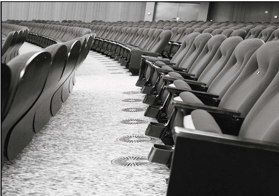
Fig 49 – Distribución de aire por creación de microclima
